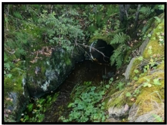
Figur 31 – Rør mot sør, tilgrensende planområdet, åpen grøft parallelt med Sundvegen ender i rør.
