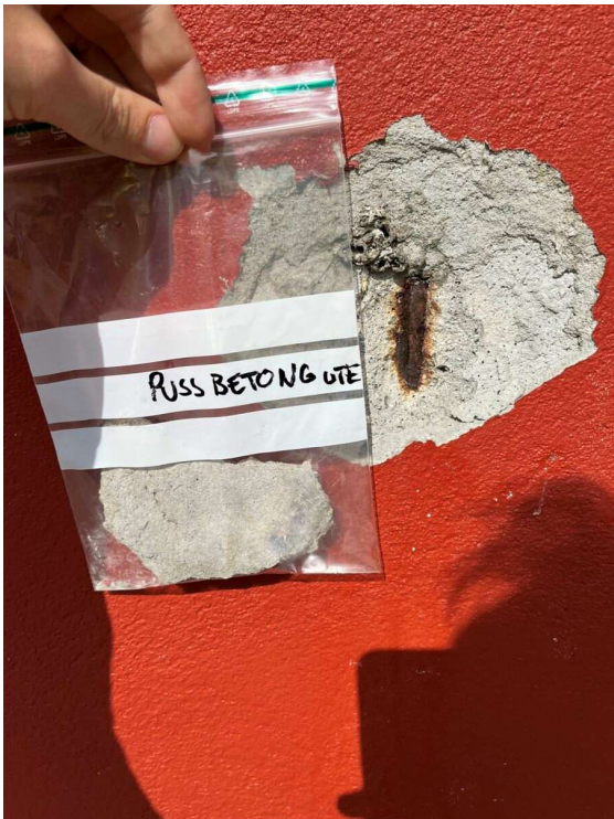
Bilde 1: Prøve av puss på utvendig betong.
