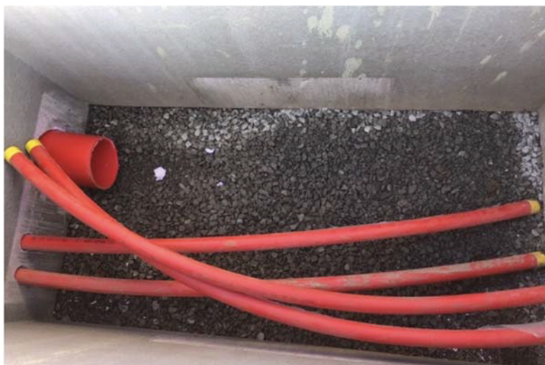
Figur 14. Innføring av rør i firkant kum
