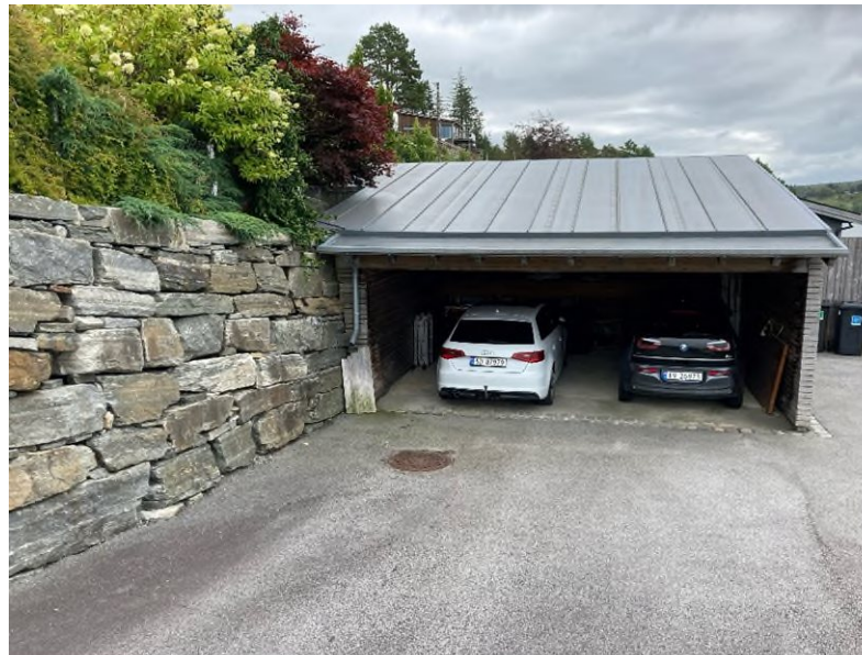
Figur 2 - Carport sett fra nord
