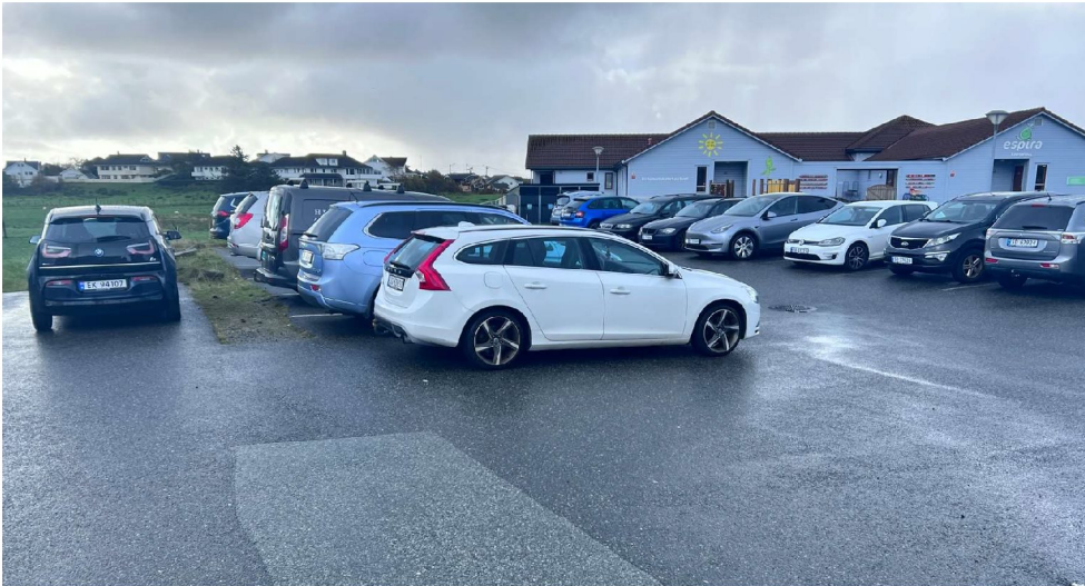
Figur 4 Bilde fra befaring den 17.10.23, midt på dagen. Parkeringsplassen var full, og det var også parkert på naboareal, samt fremfor inngangsporten. Ideelt sett bør inngangsporten være åpen, slik at nødetater kommer raskt frem til stedet ved behov.
