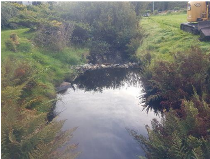
Figur 1. FØR fjerning av terskel og utlegg av gytegrus.
