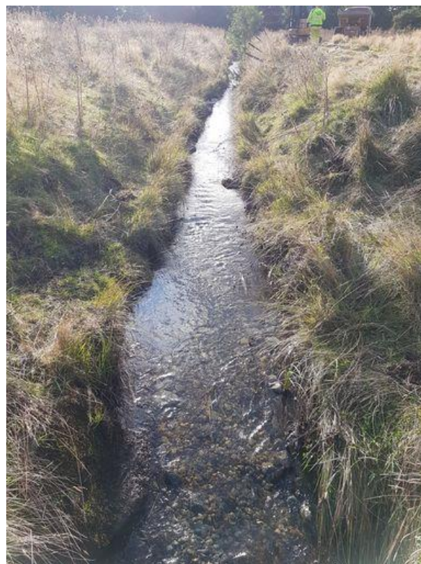
Figur 6. ETTER utlegg av gytegrus i segment 16.
