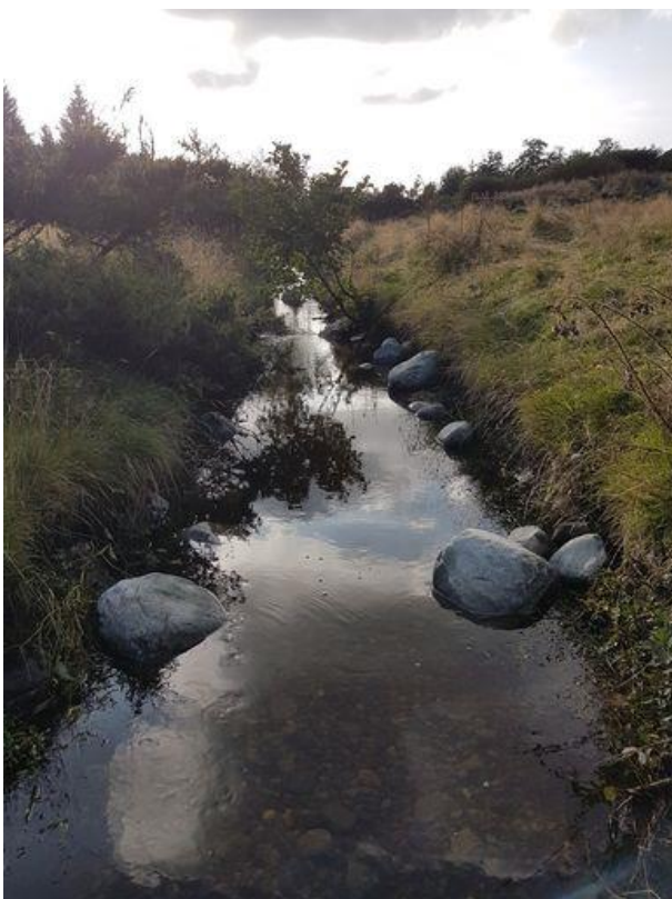
Figur 5. ETTER utlegg av gytegrus i segment 16. Sett fra bro og oppstrøms.
