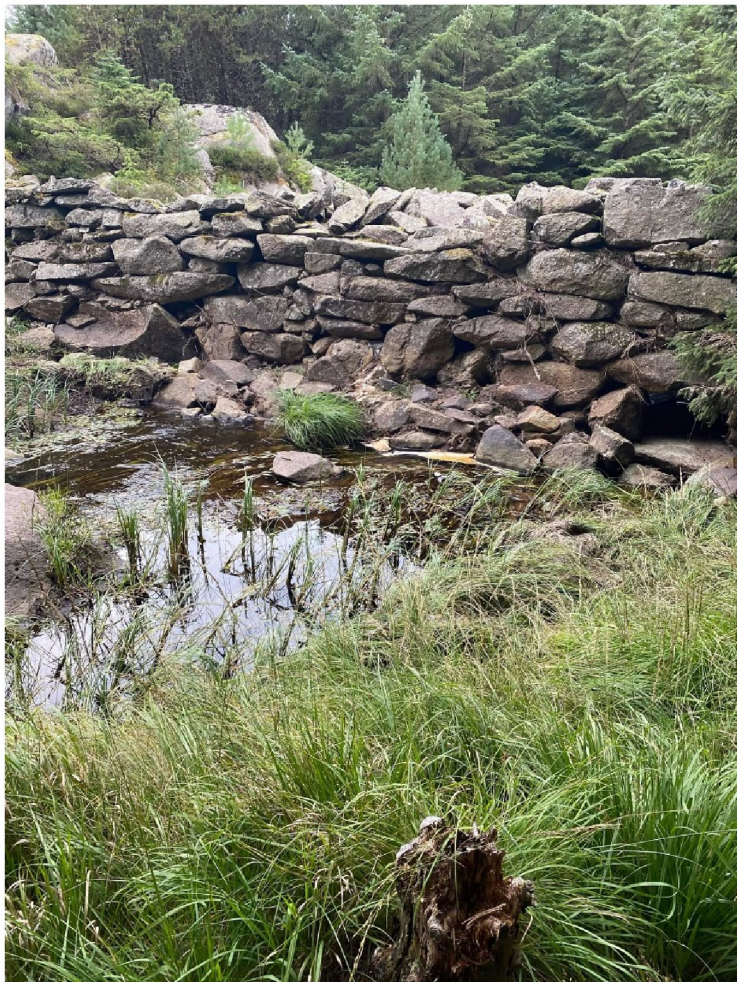
Før tiltak. Vannstanden i dammen på oversiden av demningen er så lav at vannet på tilnærmet alle vannføringer ikke renner ut av åpningen til høyre i bildet. Istedenfor sildrer vannet mellom steinene i hele demningens tverrsnitt.
