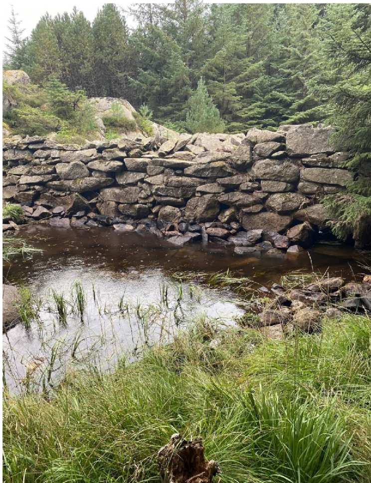
Etter tiltak. Vannstanden i dammen steg umiddelbart, slik at vannet sto 20 cm over bunnen på åpningen. Nå vil det på nær sagt alle vannføringer være mulig for nedvandrende fisk å vandre ut av dammen.
