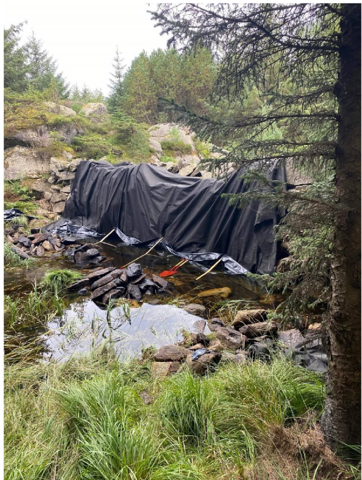
Stein som lå inntil demningen (for å tette) ble tatt bort, og to duker lagt dobbelt. Stein ble lagt inni dukene som en kjerne og senke dem ned på dambunnen. Resterende stein ble kledd utpå dukene for å holde på og beskytte disse.
