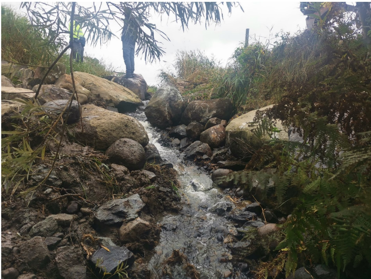
I østre bredd ble det laget en renne som sikrer oppgang av voksen gytefisk.
