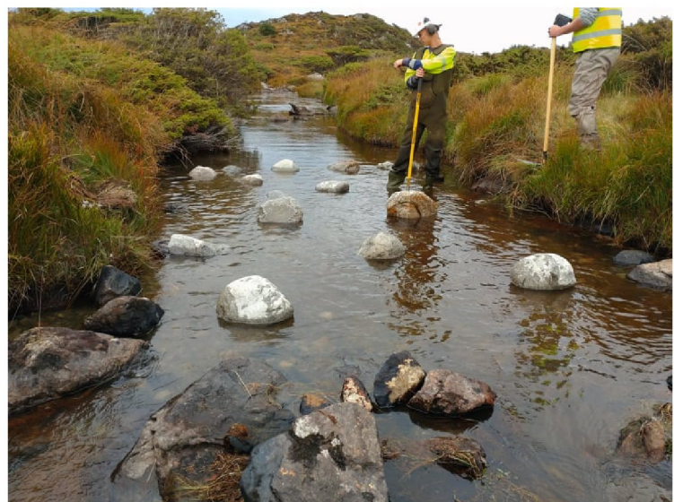
Etter grusutlegg i segment 66.
