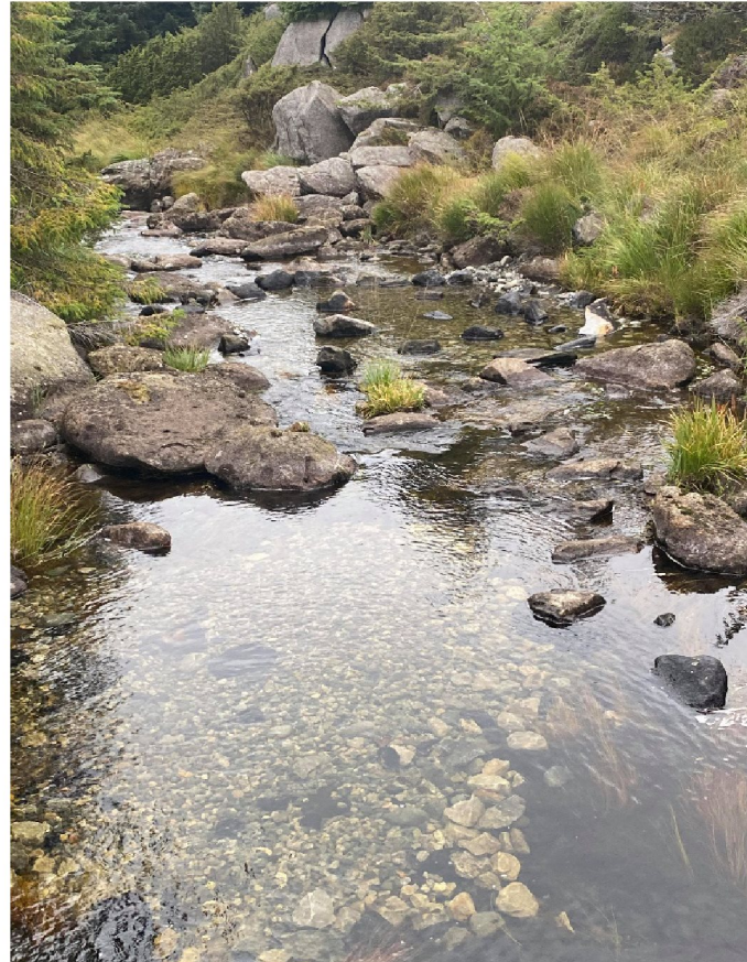
Etter grusutlegg i segment 60. I kulpen nærmest kamera ble det i samråd med konsulent i felt, besluttet å legge ut ca. 3 m 2 med ekstra grus. Det gikk litt mindre grus i hovedkulpen enn forventet.
