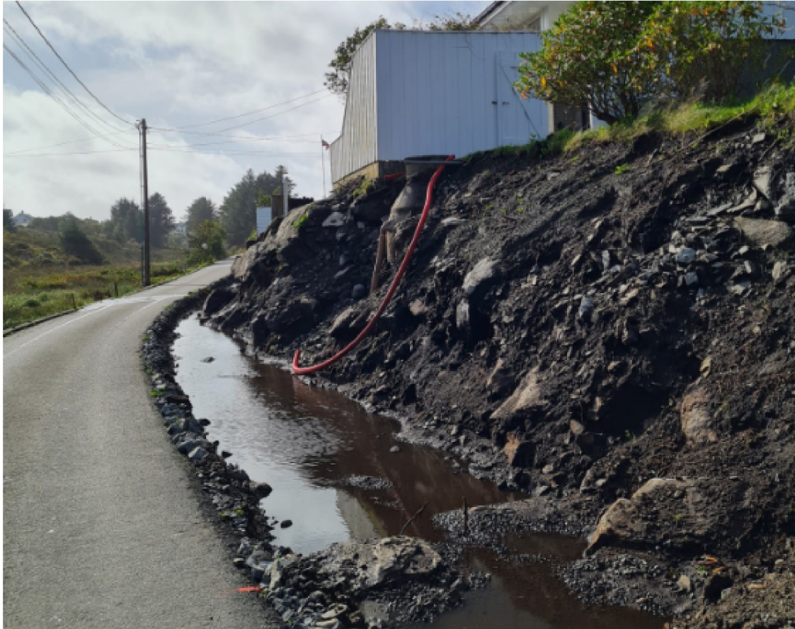
Foto dagens situasjon- foto Sektor Samferdsel september 2023
