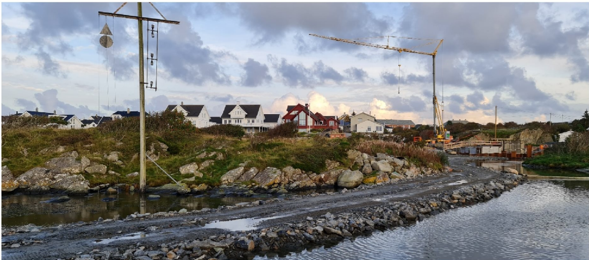
Figur 13 – brokar for gangbro blir ført opp i naturstein til høyre for stolpen på holmen se KAP5.
