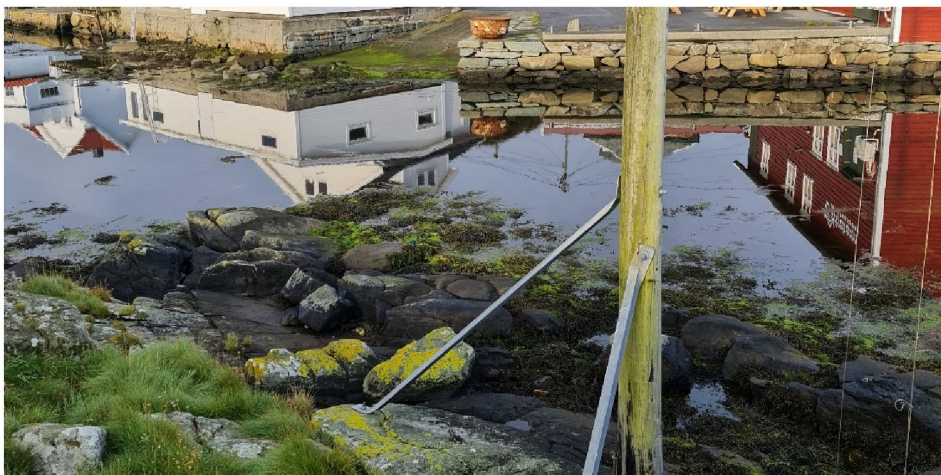
Figur 11 – brokar for gangbro blir ført opp i naturstein til vestre for stolpen på holmen se KAP5.
