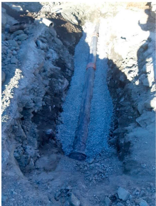
Figur 9 - Utbytting av rørstrekning mellom D3 og K3.
