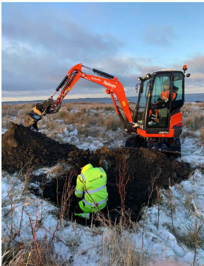
Måling av gass i gravegrop
