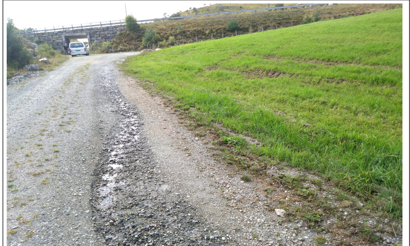
1. Felt 1, sørlig hjørne – mot Gamle Kyrkjevegen.
