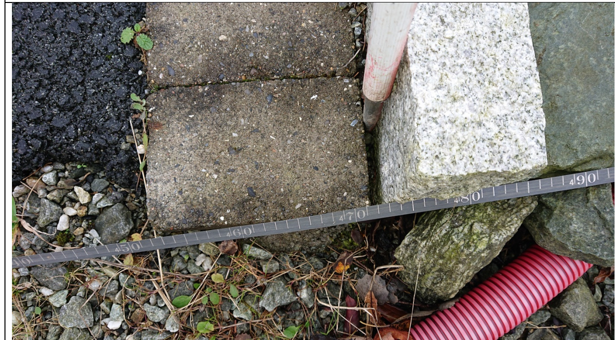
Bilde 6: P2 – oppmålt vegbredde mellom stikningsstengene (se bilde 5).
