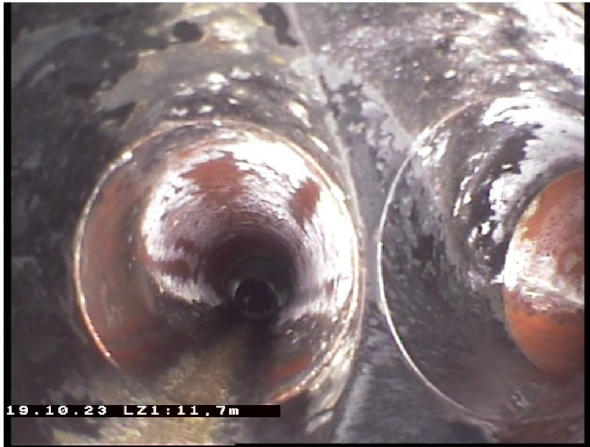
20.10.2023 145146_End_ Grøft ved gjerde_19102023_073022_006.jpg, 00:01:50, 11.70m Tilkobling. Prefabrikkert grenrør på 3 Kl.
