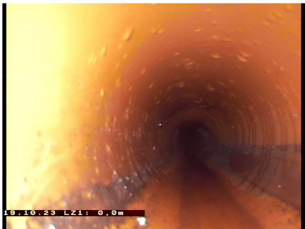
20.10.2023 145243_Endre_Grøft ved gjerde_19102023_072710_008.jpg, 00:00:00, 0.00m Start inspeksjon, 0%
