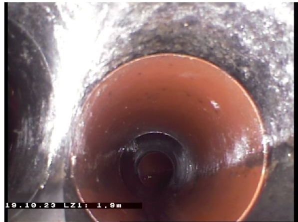
20.10.2023 145146_Endre_Grøft ved gjerde_19102023_073022_003.jpg, 00:00:14, 1.90m Tilkobling. Prefabrikkert grenrør på 3 Kl.
