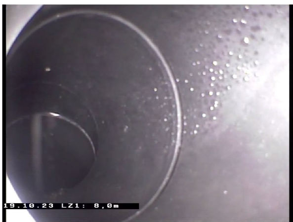
20.10.2023 145243_Endre_Grøft ved gjerde_19102023_072710_010.jpg, 00:01:02, 8.00m Tilkobling. Prefabrikkert grenrør på 3 Kl.
