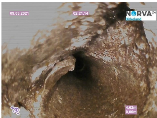
Spillvann_Septiktank_Påkobling hovedledning_20210309_135633.jpg
