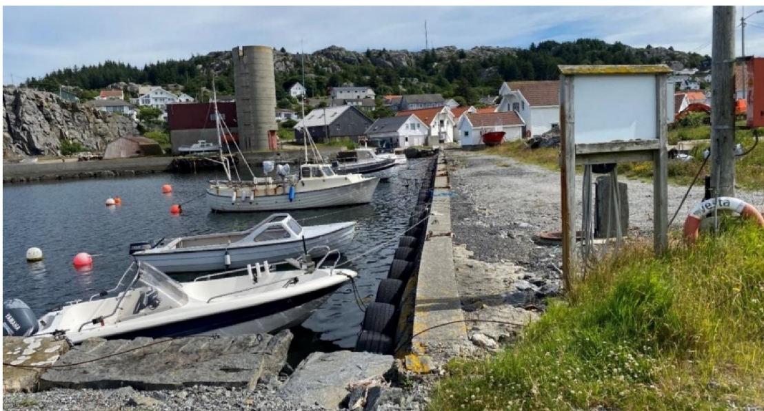
Figur 15 – Støpt betongkant i brygge vest i planområdet.
