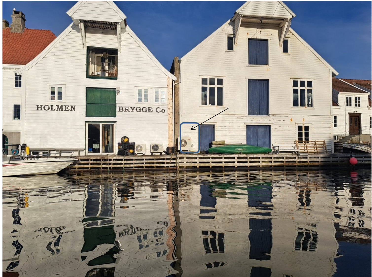
Pilen viser ønsket plassering av ny varmepumpe over den gamle
