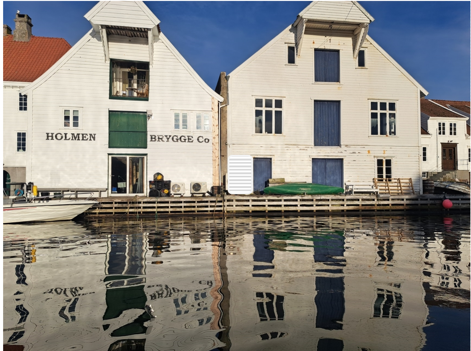
Plassbygget hus til deksel av begge varmepumpene
