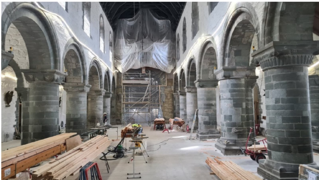
Stavanger domkirke ligger ved nøkkelsted Stavanger, og er for tiden under omfattende restaurering
