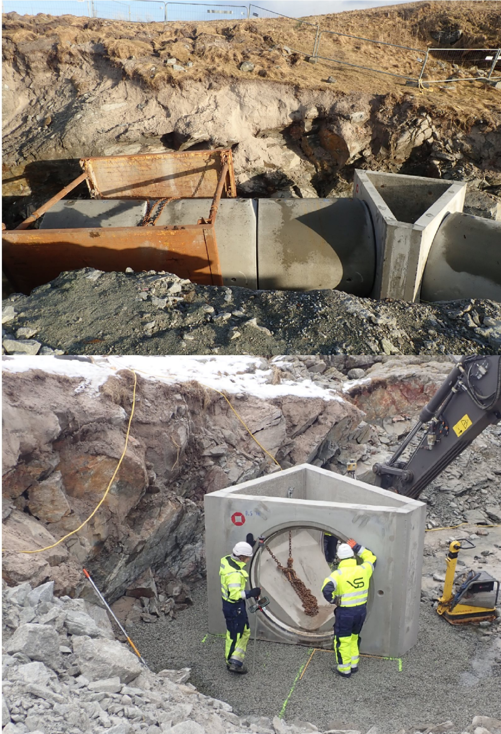
Bilde 6 og 7 : Ny ledning DN 1600 betongledning (ca. 2 meter utvendig). Like under plastringsfot.
