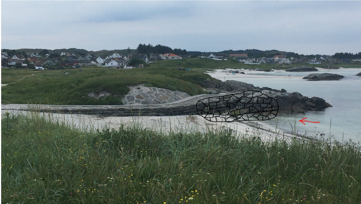
Bilde 12. Plassering av steinfylling for å stoppe bølgeretning som forårsaker skade på sanddyne.
