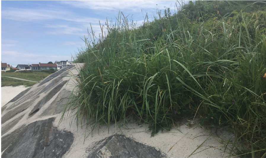
Bilde 14. Plastring og sikring av Sanddyne. Utført etter storm februar 2020. Vegetasjon gror og legger seg over plastring
