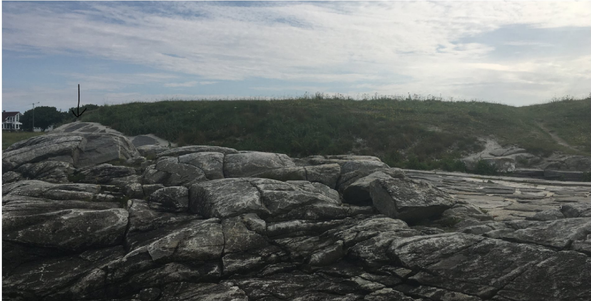
Bilde 2. Plastring sett fra fjell og sjøsiden
