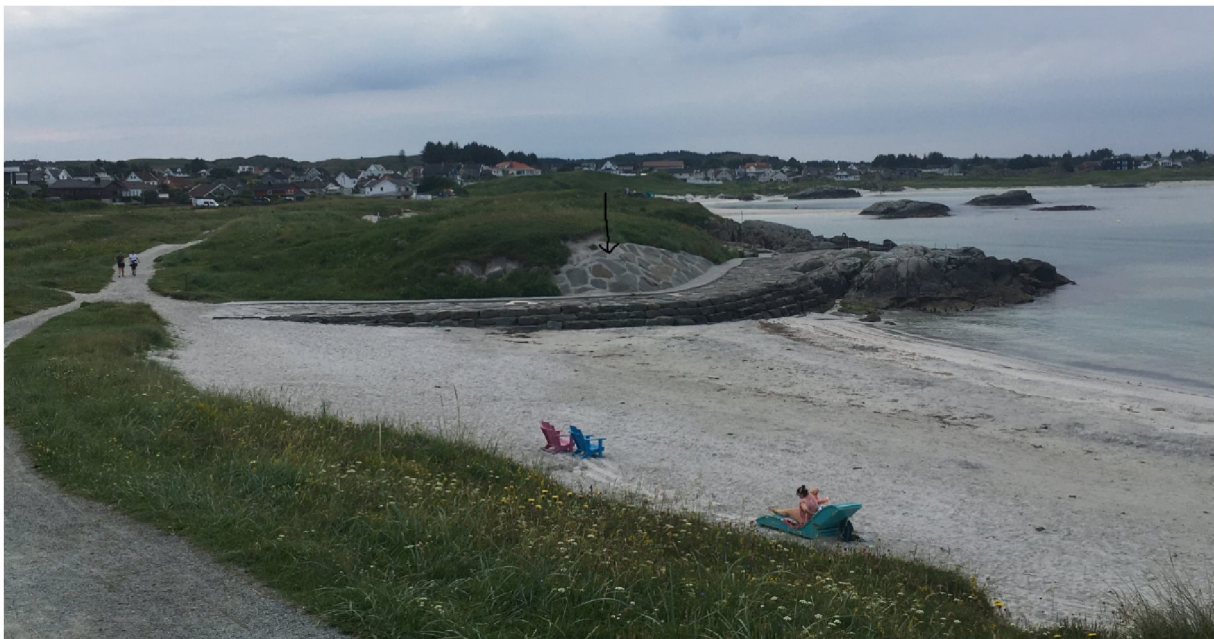
Bilde. 3 Plastring sett fra gangveg nordvest for Hedleklubben
