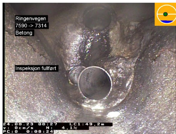
24.08.2023 080713_7314_7590_24082023_080913_009.jpg, 00:08:21, 49.20m Inspeksjon fullført
