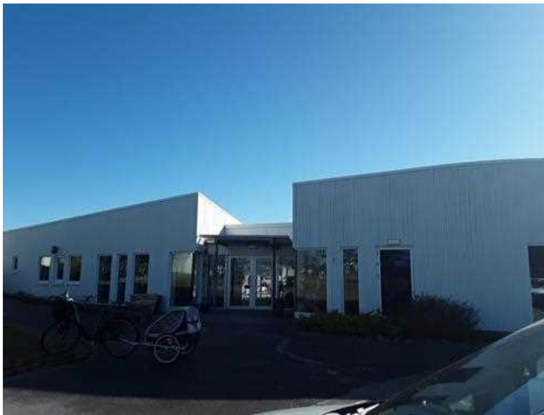
Kommentarer etter besøk - [Fasade/objekt]
