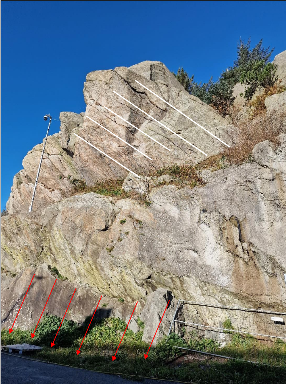
Foto 10: Markering av dominerende strukturer i bergmassen. Farger samsvarer med tabell 2.
