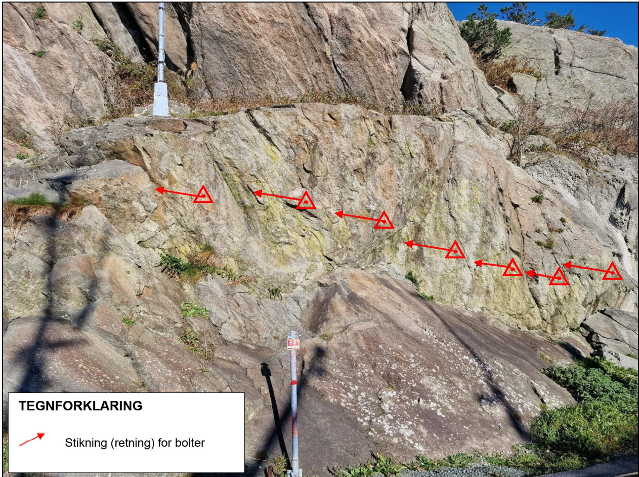
Foto 12: Anvist bergsikring i østre del av skjæring. Merk at stikning markerer vinkling av boltene iht. til horisontalplanet, og ikke reell orientering.
