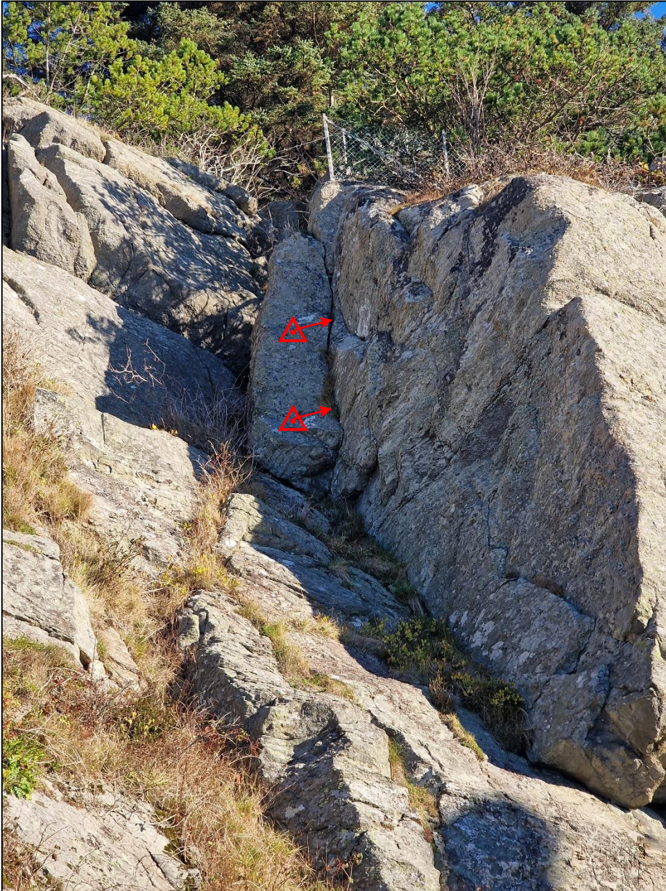
Foto 16: Anvist bergsikring i vestre del av skjæring. Merk at stikning markerer vinkling av boltene iht. til horisontalplanet, og ikke reell orientering.
