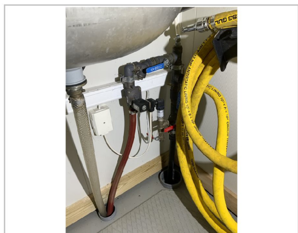
Mangler tilbakeslagsventil kat. 5
