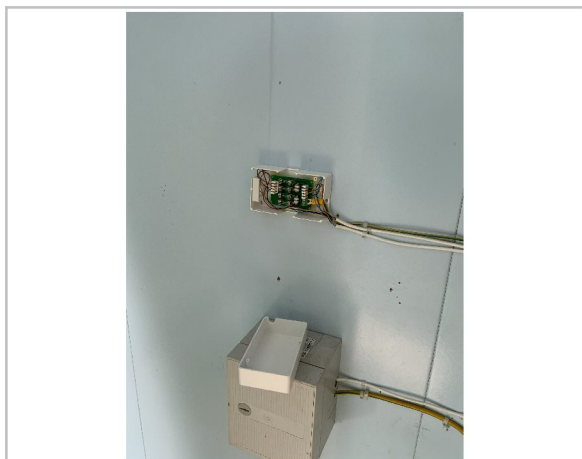
Rister nede i sump er åpne
