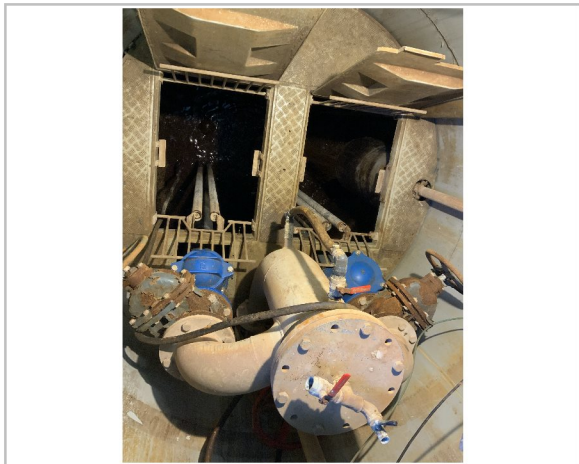
Åpne sikkerhetsrister nede i sumpen.
