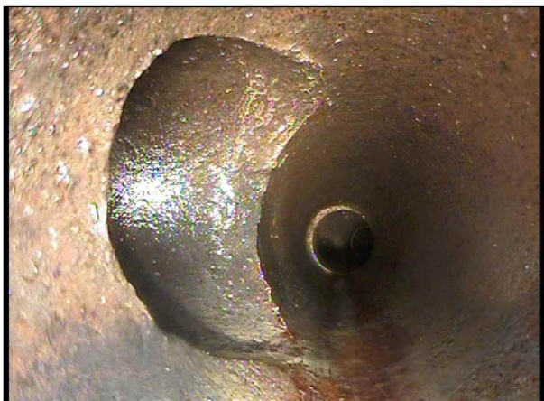
Foto: Stakeluke inne_Påkobling_104734.jpg 4,58m, Tilkobling Prefabrikkert grennrør., 9 Kl.
