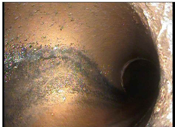
Foto: Stakeluke inne_Påkobling_104821.jpg 7,11m, Tilkobling Prefabrikkert grennrør., 9 Kl.
