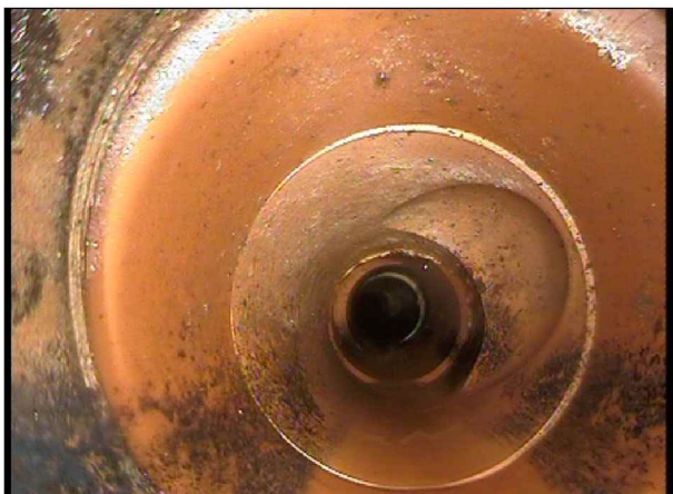
Foto: Stakeluke inne_Påkobling_104630.jpg 3,02m, Materialendring til PLA
