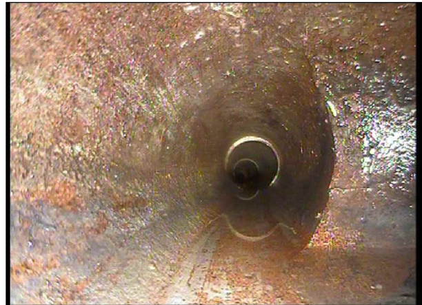
Foto: Stakeluke inne_Påkobling_104600.jpg 1,07m, Tilkopling Prefabrikkert grenrør., 3 Kl.
