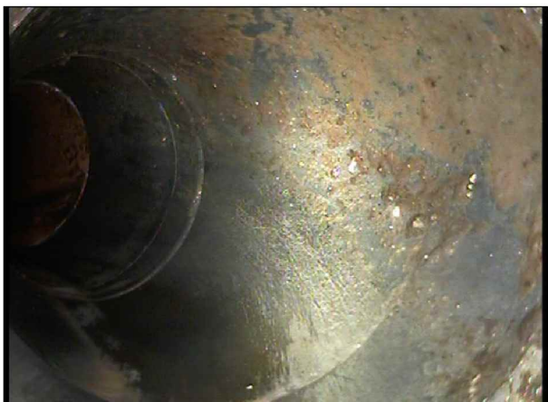
Foto: Stakeluke inne_Påkobling_104924.jpg 10,37m, Retningsendring 9 Kl., Prefabrikkert bend
