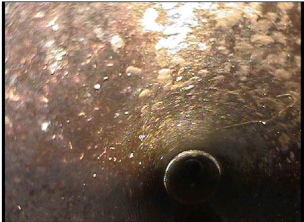
Foto: Stakeluke inne_Påkobling_104527.jpg 0m, Start inspeksjon Vannstand: 0 %
