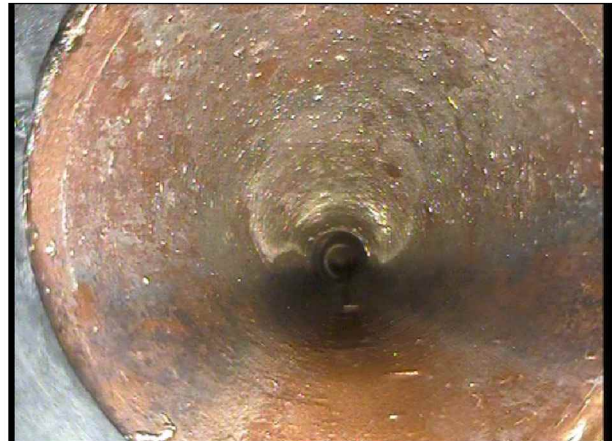
Foto: Stakeluke inne_Påkobling_104714.jpg 3,58m, Materialendring til LER
