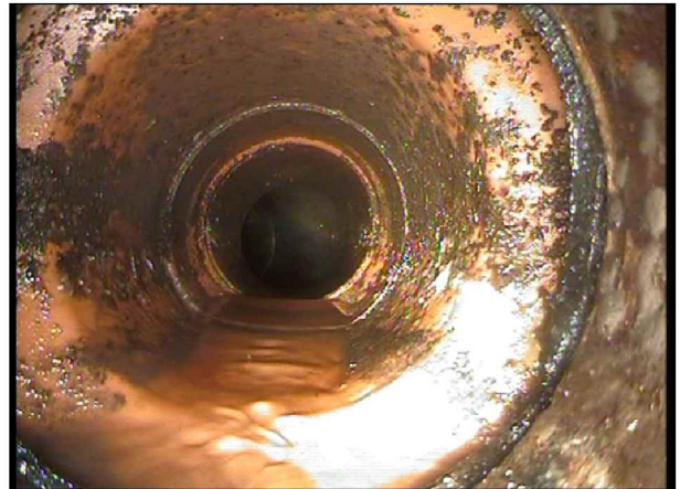
Foto: Stakeluke inne_Påkobling_104908.jpg 10,01m, Materialendring til PLA
