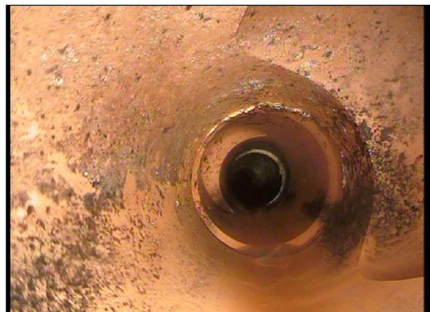
Foto: Stakeluke inne_Påkobling_104644.jpg 3,15m, Tilkopling Prefabrikkert grenrør., 2 Kl.
