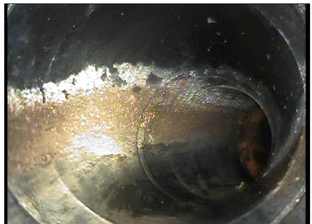
Foto: Stakeluke inne_Påkobling_105036.jpg 27,44m, Retningsendring 3 Kl., Prefabrikkert bend
