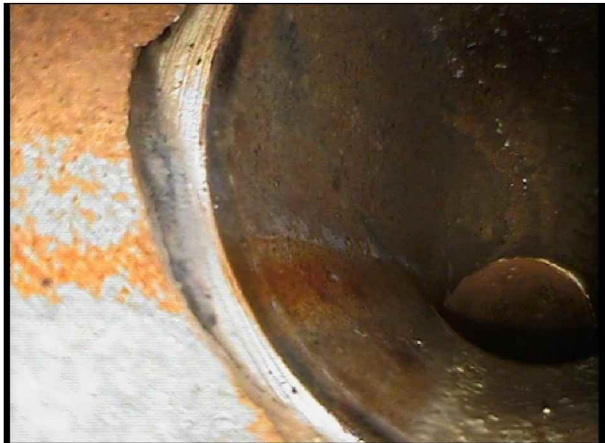
Foto: Toalett 1etg_Påkobling_080349.jpg 0m, Start inspeksjon Vannstand: 0 %
