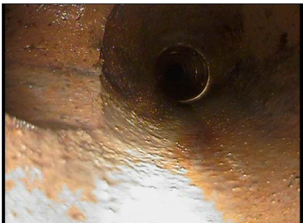
Foto: Toalett 1etg_Påkobling_080436.jpg 0,62m, Tilkopling Prefabrikkert grenrør., 9 Kl.
