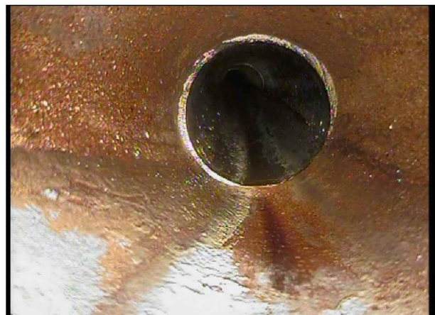
Foto: Toalett 1etg_Påkobling_080459.jpg 1,74m, Retningsendring 12 Kl., Prefabrikkert bend
