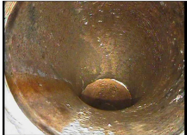
Foto: Toalett 1etg_Påkobling_080401.jpg 0m, Retningsendring 6 Kl., Prefabrikkert bend
